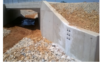
Mur et extension en béton recyclé
